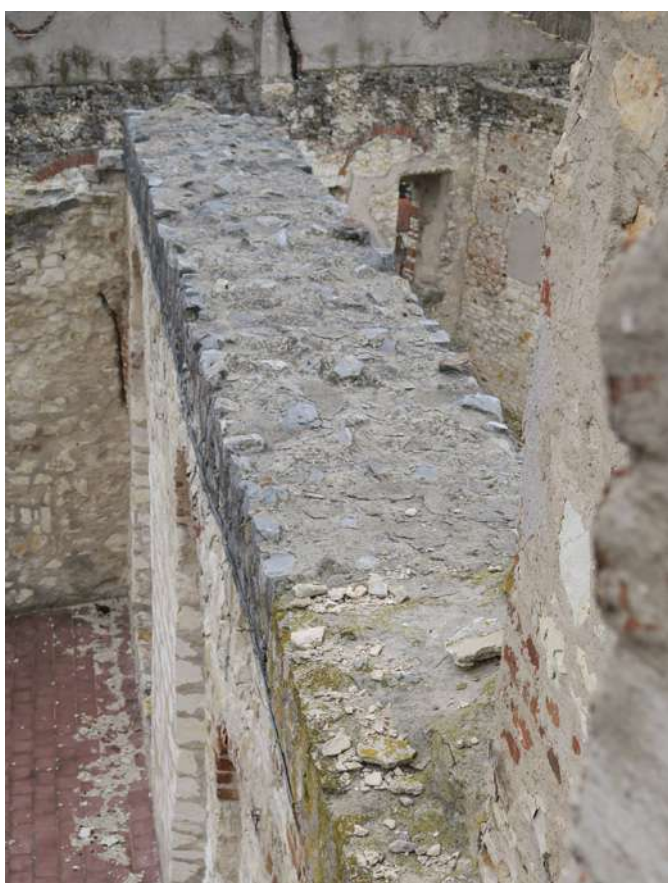
Zabezpieczenie korony murów (fot. A.S.)
