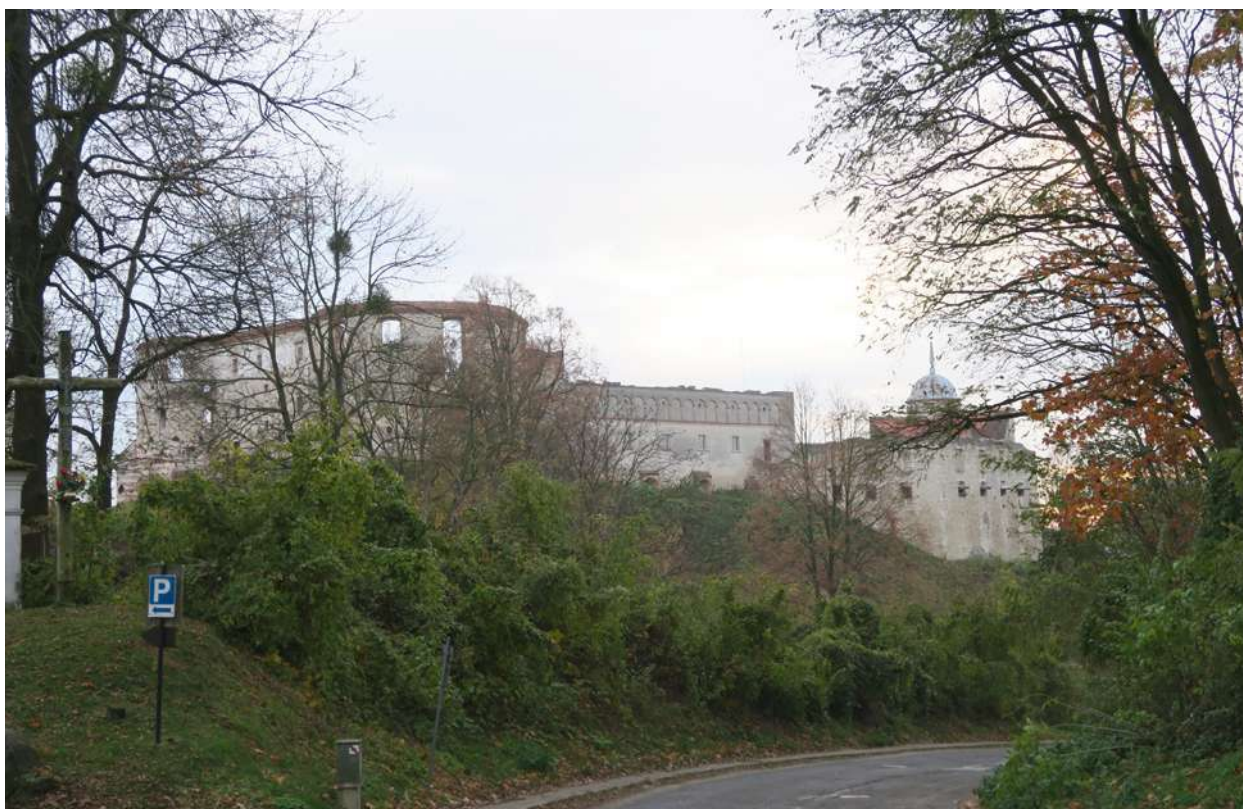
Widok zamku z północnego wschodu (fot. A.S.)
