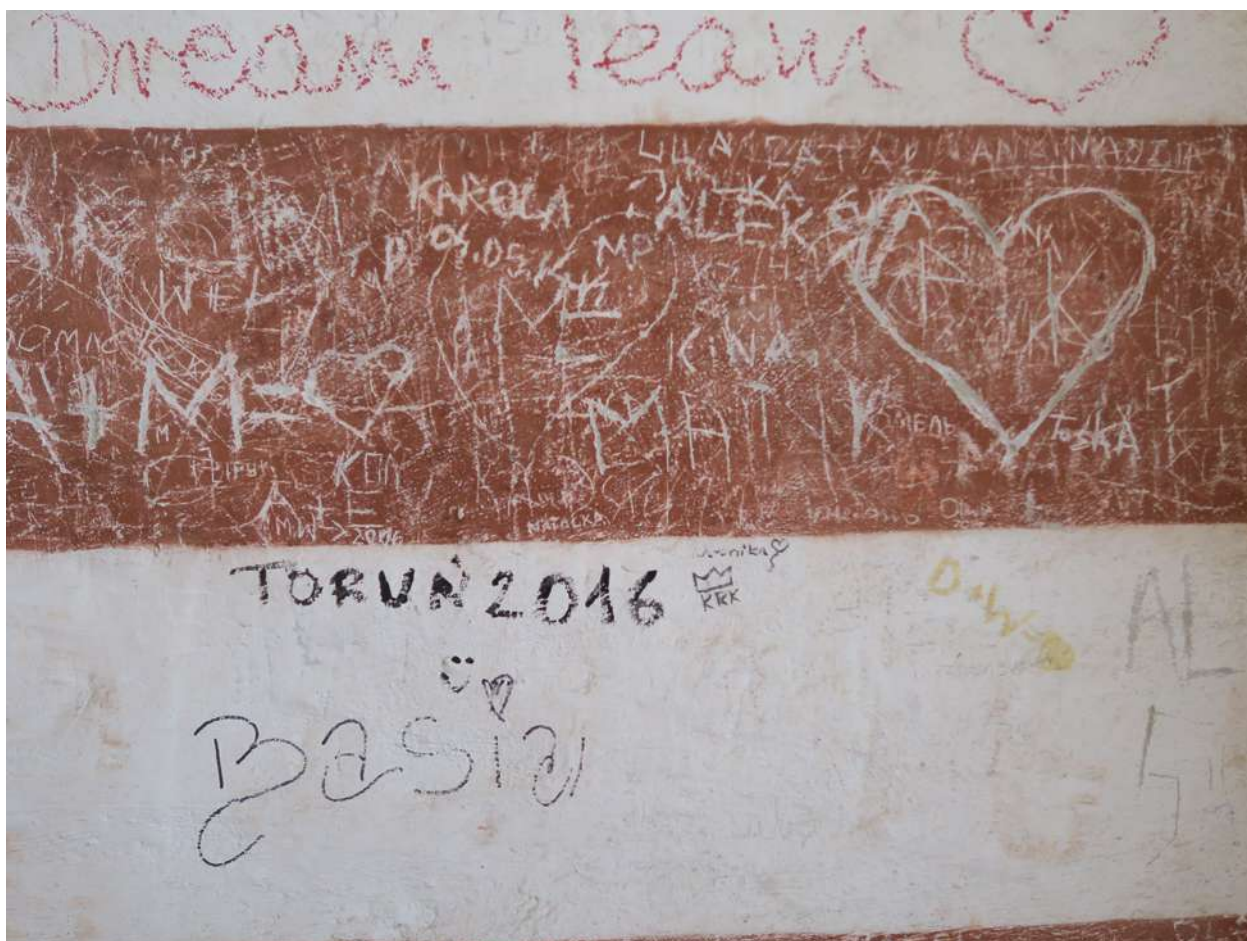
Zagrożenie – dewastacja elewacji związana z ruchem turystycznym (fot. A.S.)
