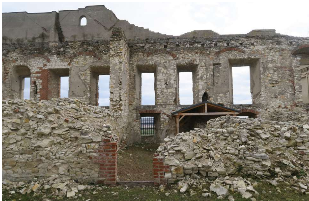
Destrukcyjna materialowa wątków kamiennych (fot. A.S.)
