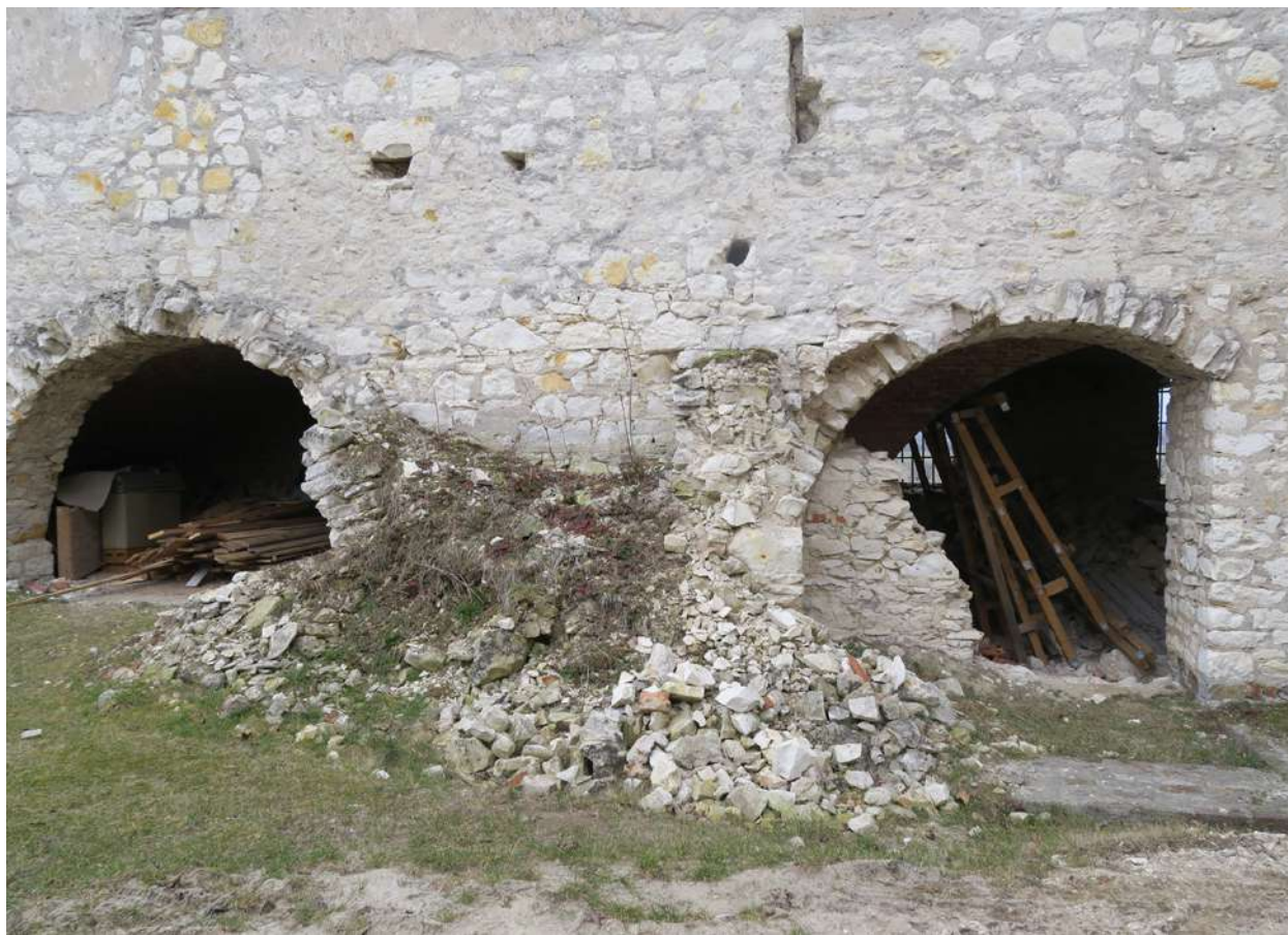
Przykład degradacji murów (fot. AFM)
