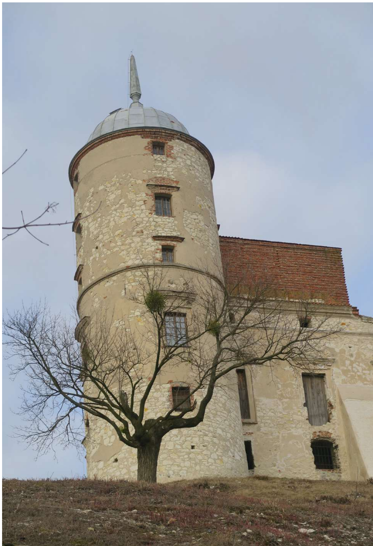
Widok zamku z północnego wschodu (fot. A.S.)
