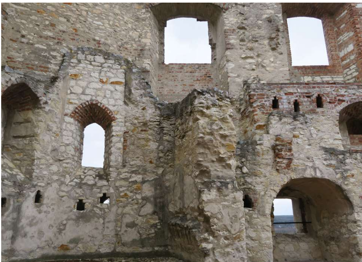
Zróżnicowanie wątków murów oraz form otworów poświadcza fazy przekształceń zamku (fot. A.S.)
