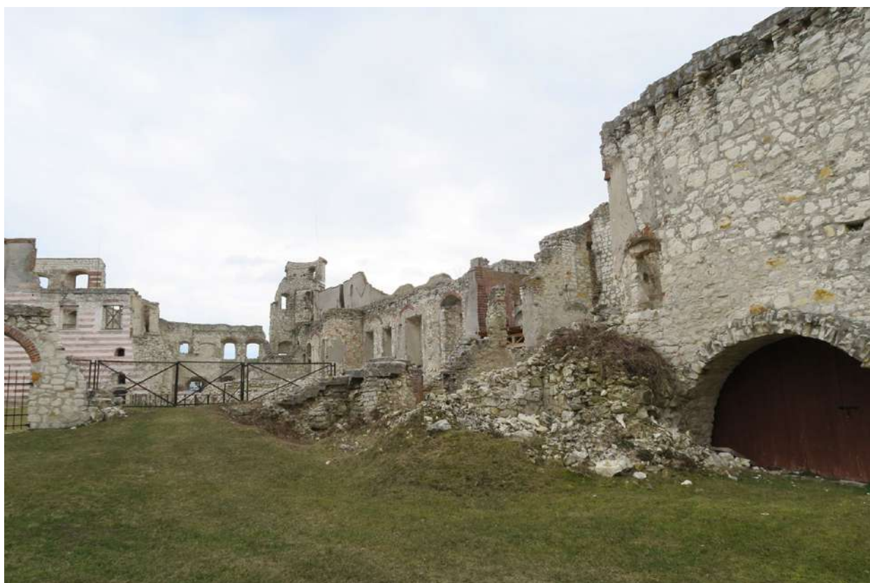
Przykład degradacji zabytkowej substancji (fot. AFM)
