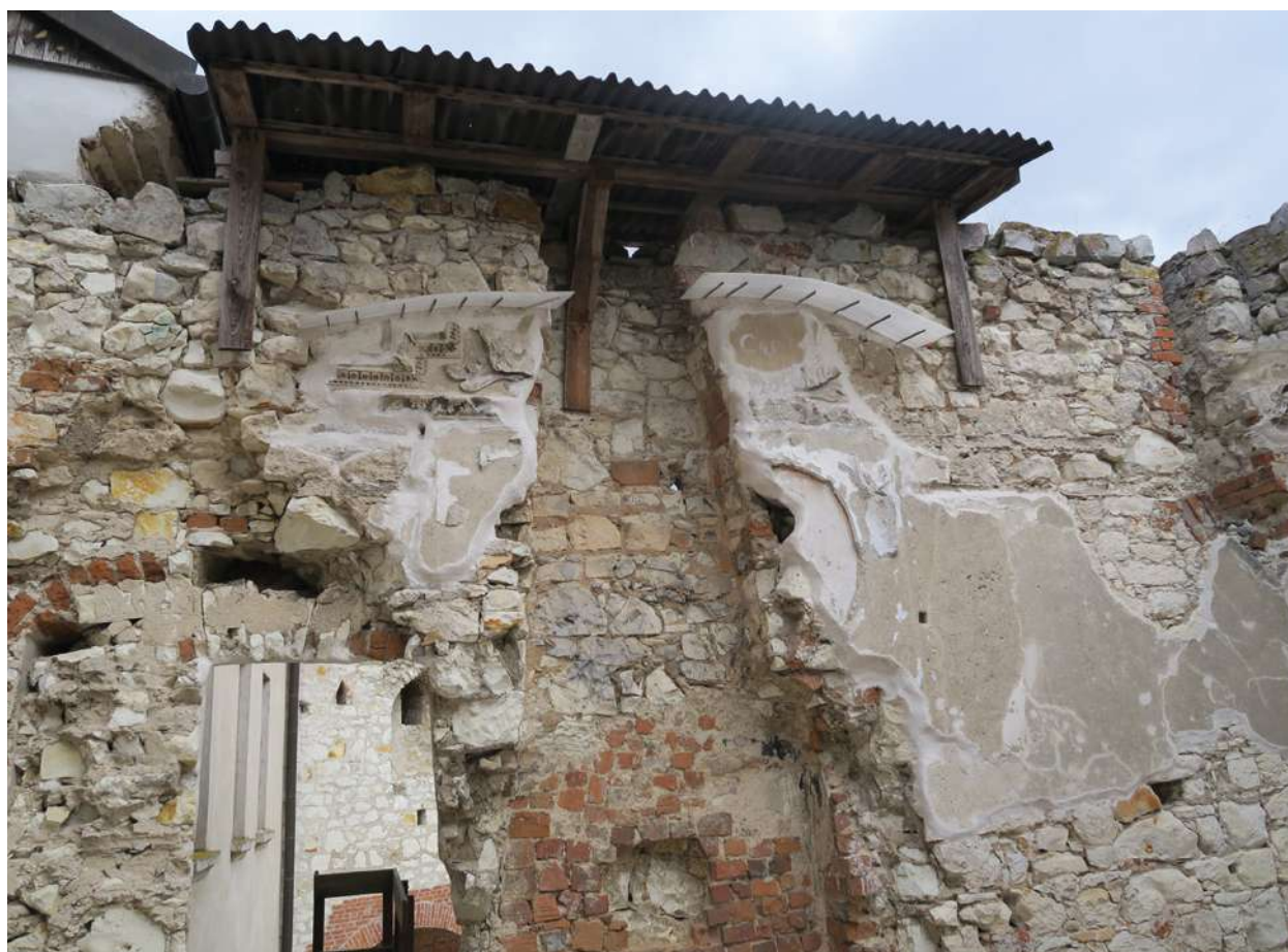
Przykład zabezpieczenia reliktyw dekoracji architektonicznej (fot. AFM)
