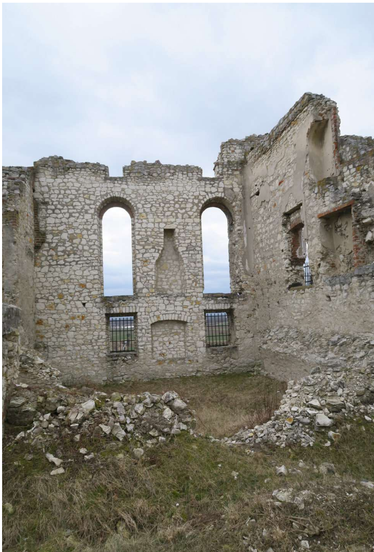
Przykład degradacji murów (fot. AFM)
