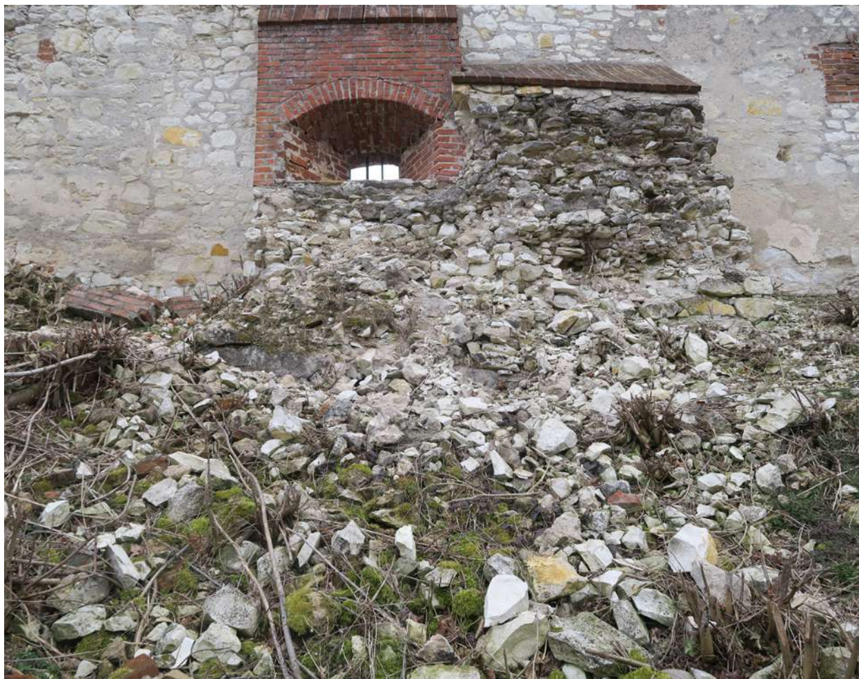
Erozja murów zamkowych (fot. A.S.)
