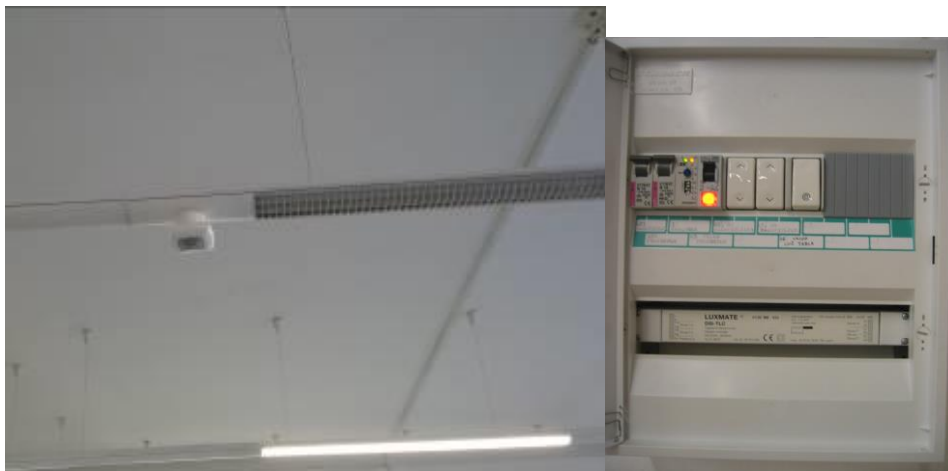
Obrázok č. 6.8: Snímač prítomnosti osôb a osvetlenia; ovládací panel osvetlenia so 4 tlačidlami
