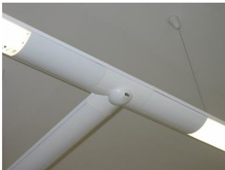
Obrázok č. 6.7: Moderné fluorescenčné svetlá s ovládaním DALI
