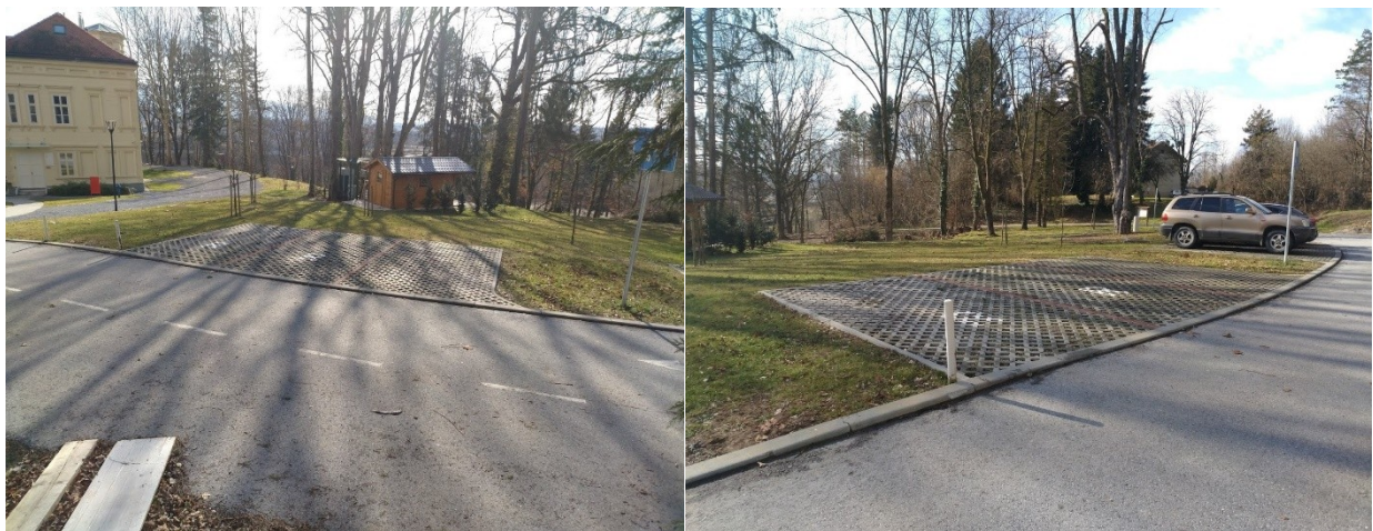
Slika 19: Mjesto izgradnje nosive konstrukcije za izgradnju fotonaponskog sustava
