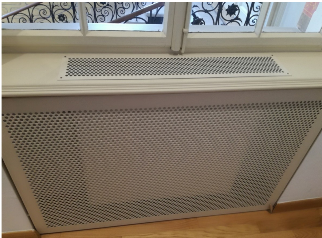
Slika 7: Prikaz vetilokonvektora
