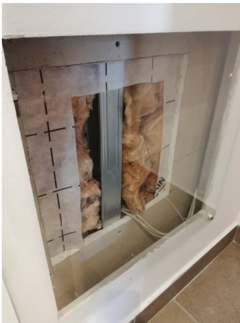
Slika 5: Detalj izolacije vanjskog zida
