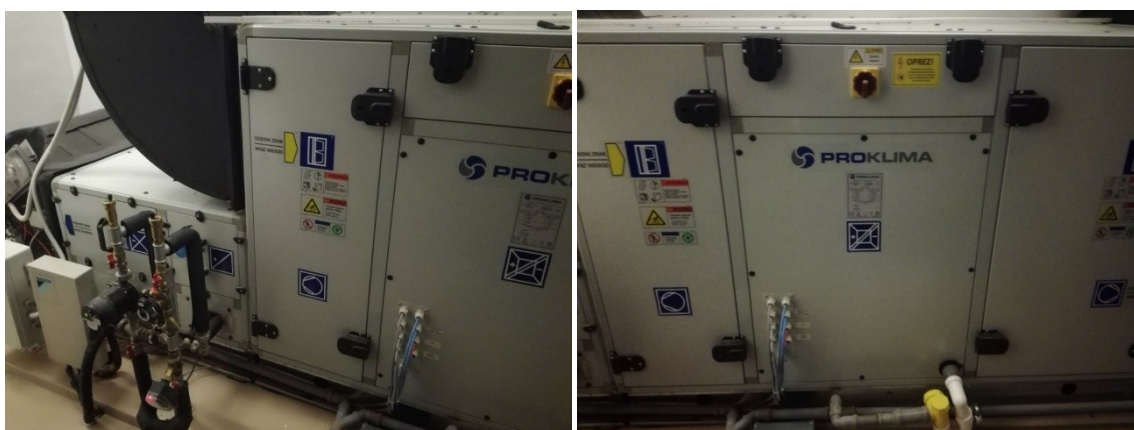
Slika 9: Sustav ventilacije KK2 u podrumu
