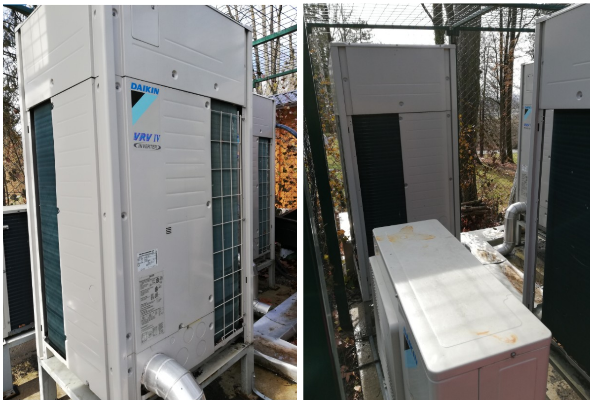
Slika 6: Prikaz vanjskih VRV jedinica Izvor: REGEA, 2019.
