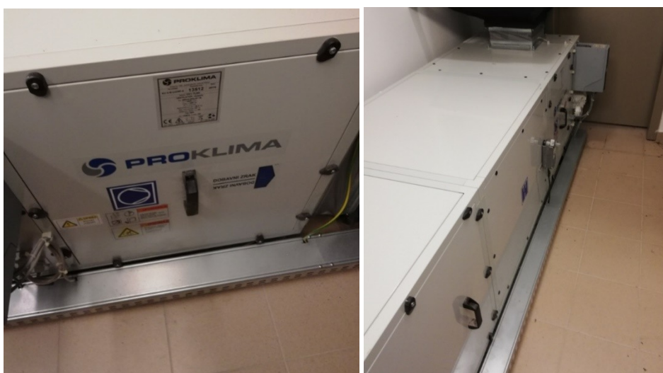
Slika 8: Sustav ventilacije KK1 u potkrovlju
