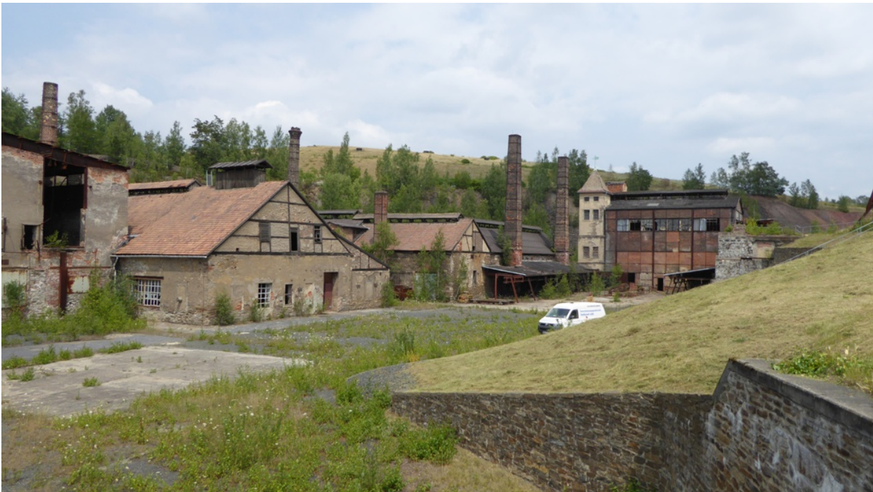
Abbildung 8: Foto derzeitige Bestandssituation (Blick vom Hüttengebäude und Schachtofen)
