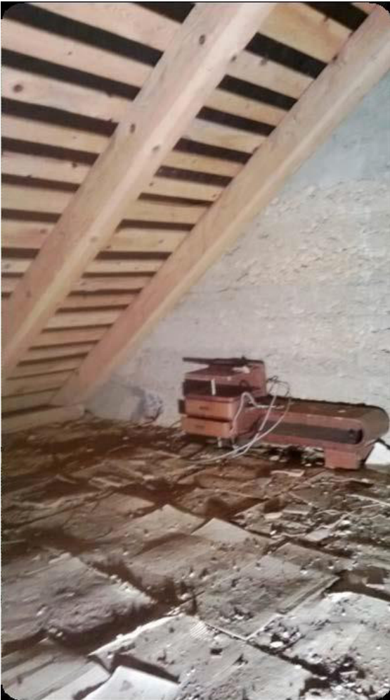
Slika 4: Postojeće stanje potkrovlja
