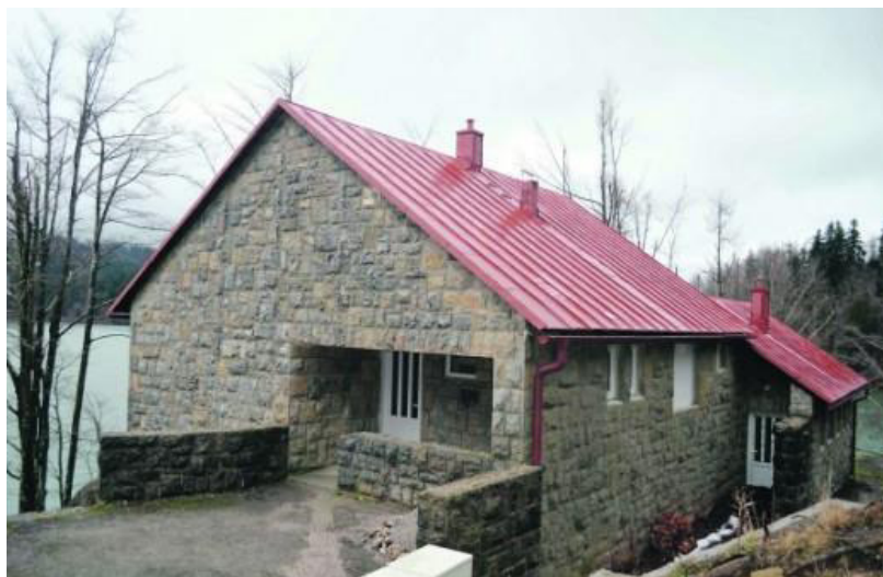
Slika 2: Tehnička kuća na brani
