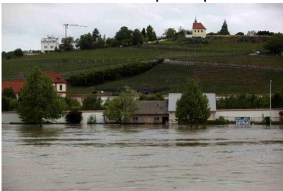
Inondazioni nel distretto di Troja nel 2002
