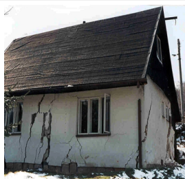
Situacija prikazuje premestitev hiše z nastankom razpok.
