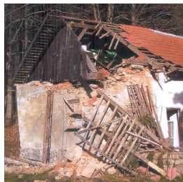
Die Situation zeigt ein durch den Umsturz eines Baumes teilweise zerstörtes Haus.
