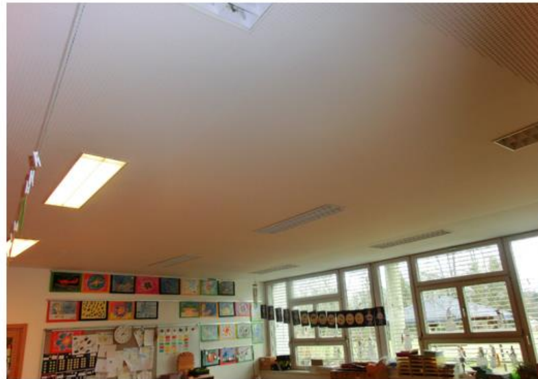
Beleuchtungsanlage VS 23 / SZ Wölfritz
