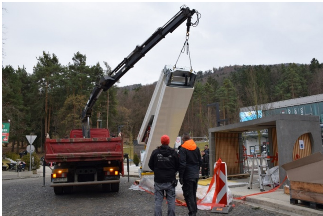
Obrázok 20: Inštalácia pantografu s rýchlonabíjačkou na stanici lanovky v Maribore
