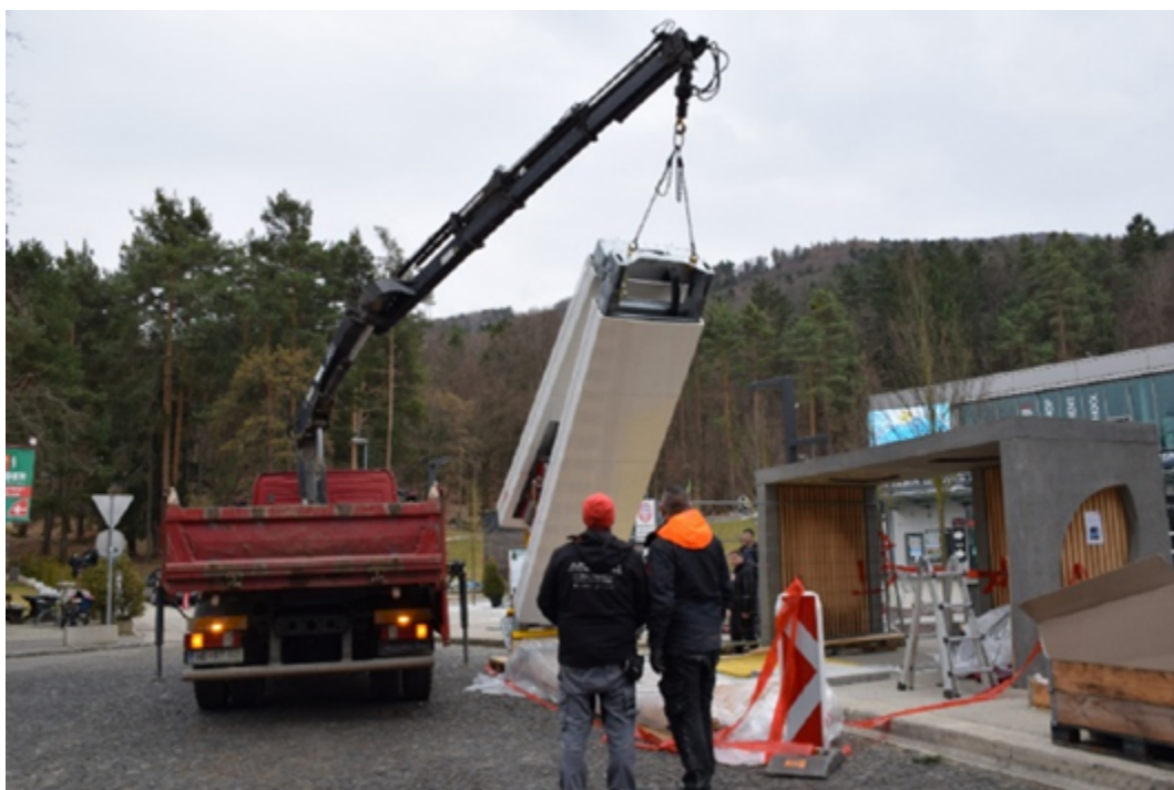
Abbildung 20: Installation eines Stromabnehmers mit einem Schnellladegerät an der Seilbahnstation in Maribor
