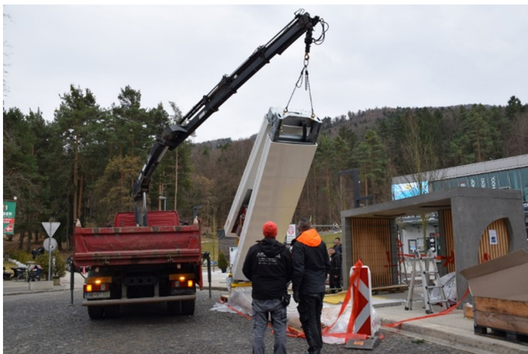
Slika 19: Ugradnja pantografa s brzim punjačem na stanici žičare u Mariboru
