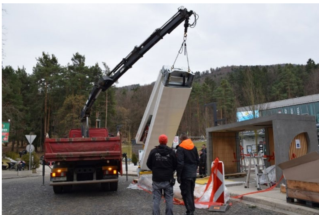
Rysunek 20: Montaż pantografu z szybką ładowarką na stacji kolejki linowej w Mariborze
