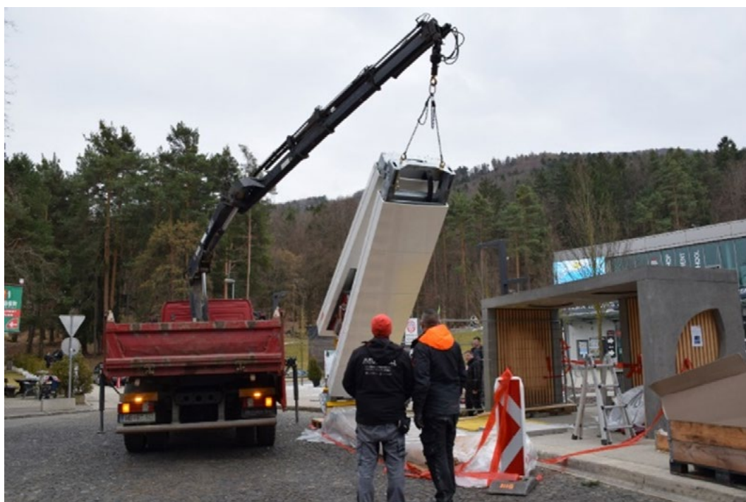
Figura 20: Installazione di un pantografo con caricatore rapido presso la stazione della funivia di Maribor
