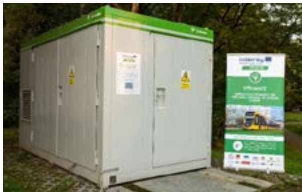
Obrázek 5: Bateriová vyrovnávací úložná stanice v Plzni (PMDP)
