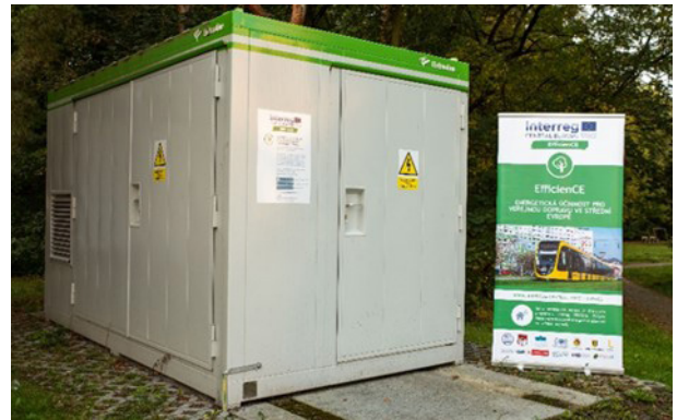
Obrázok 5: Batériová vyrovnávacia stanica v Plzni (PMDP)
