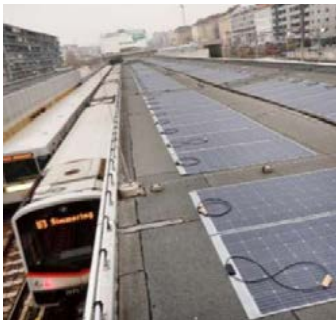
Obrázek 8: FV-fólie na střeše stanice metra (Wiener Linien)
