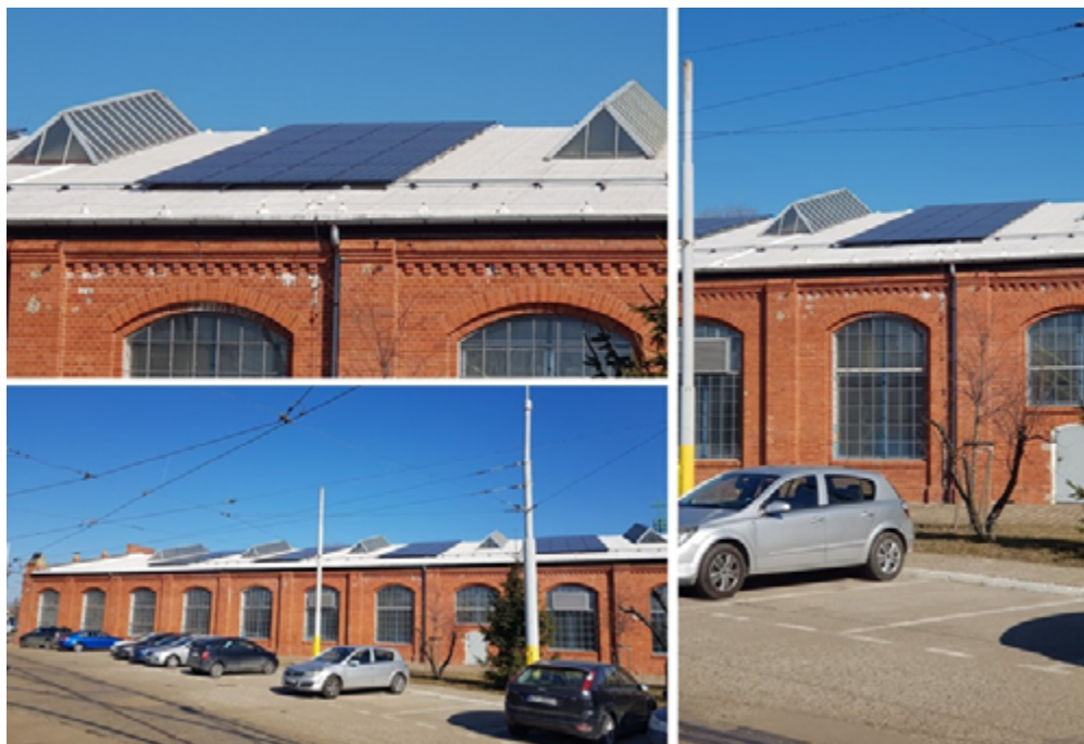
Rysunek 12: Instalacja fotowoltaiczna na dachu zajezdni tramwajowej MPK Wrocław (fot. Marcin Wolek)
