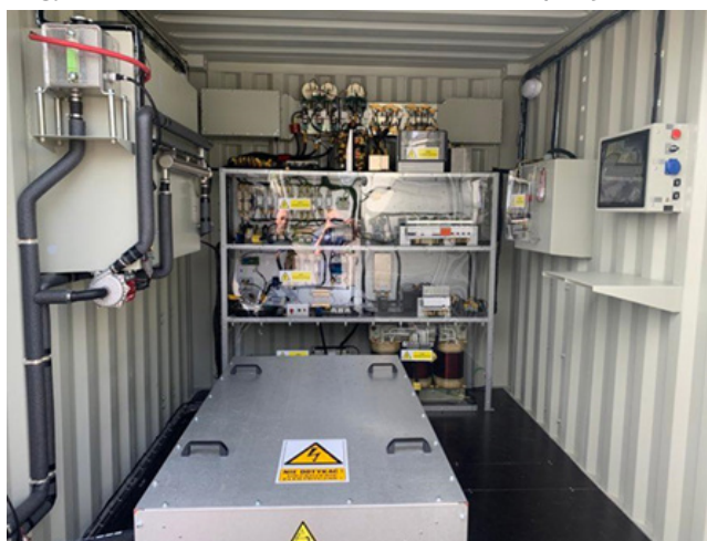
5. ábra: Akkumulátoralapú elektromos energiatárolás; egy trolibuszból származó, második életciklusú vontatási akkumulátor felhasználása. Forrás: PKT.
