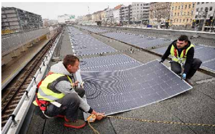
Slika 6: Ugradnja fotonaponskih folija u Beču. Izvor: WL.
