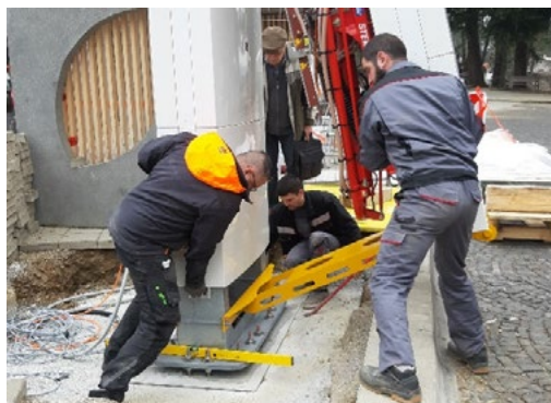
Figura 15: Installazione di un caricatore rapido a Maribor. Fonte: Città di Maribor.
