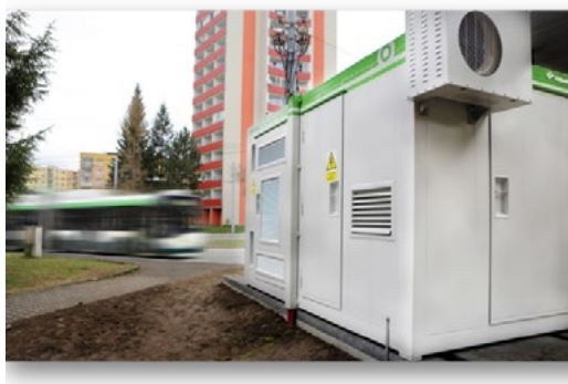
Rysunek 10: Spółka PMDP testowała stację magazynowania buforowego z trolejbusem IMC, który ma zastąpić autobusy z silnikiem Diesla. Źródło: PMDP.
