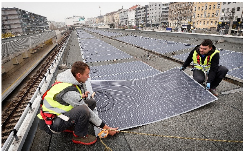
6. ábra: PV-fólia telepítése Bécsben. Forrás: WL.
