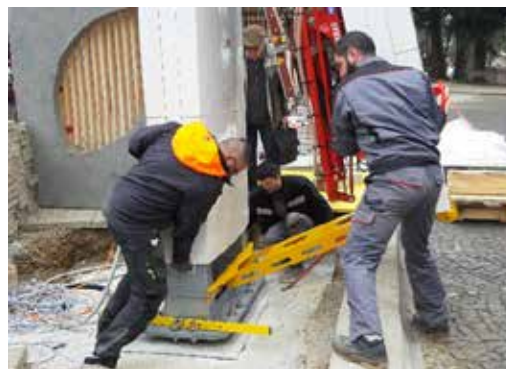
Slika 15: Ugradnja brzog punjača u Mariboru. Izvor: Grad Maribor.
