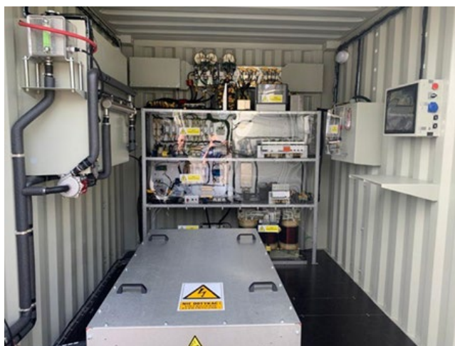
Figura 5: Accumulo di energia elettrica a batteria; utilizzo di una batteria di trazione di seconda vita di un filobus. Fonte: PKT.
