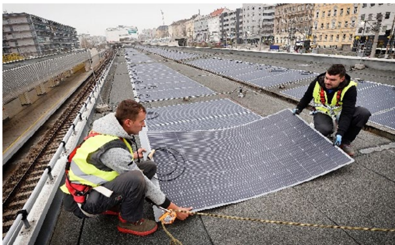
Rysunek 6: Instalacja folii fotowoltaicznych w Wiedniu. Źródło: WL.
