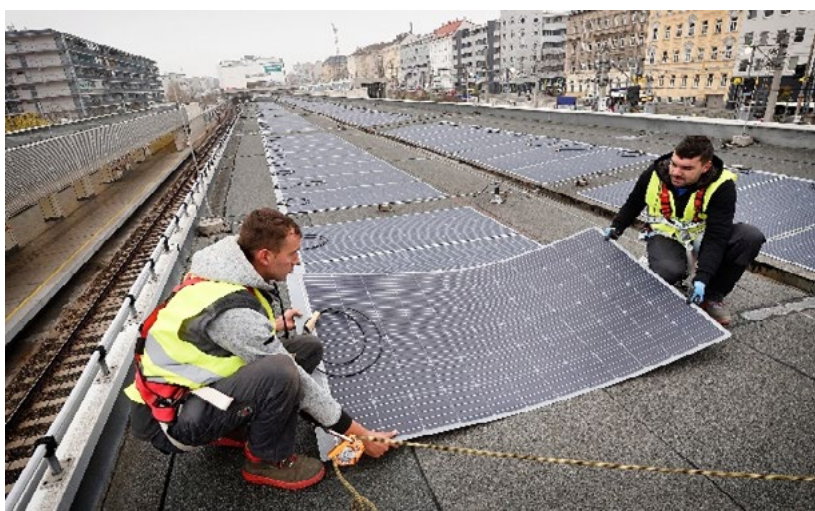
Figura 6: Installazione di fogli FV a Vienna. Fonte: WL.
