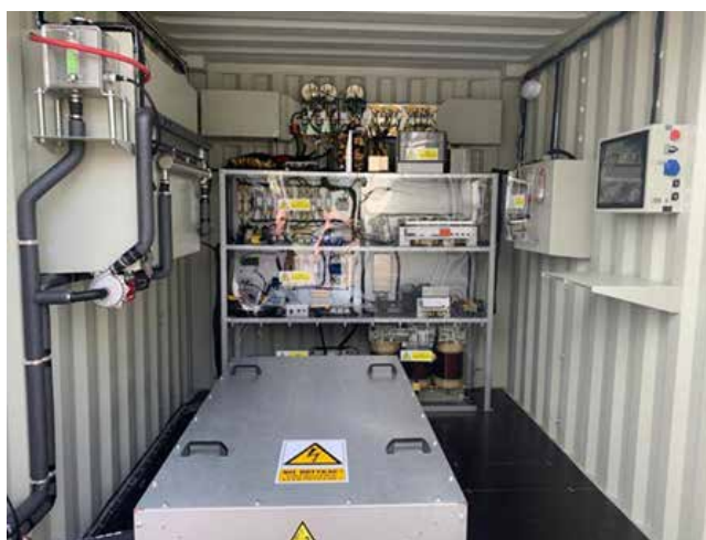
Slika 5: Pohrana električne energije u akumulatoru; korištenje vučnog akumulatora drugog životnog vijeka iz trolejbusa. Izvor: PKT.
