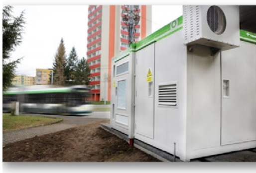
Figura 10: PMDP ha testato una stazione di accumulo di riserva con un filobus con ricarica rapida in movimento (IMC) per sostituire gli autobus diesel. Fonte: PMDP.
