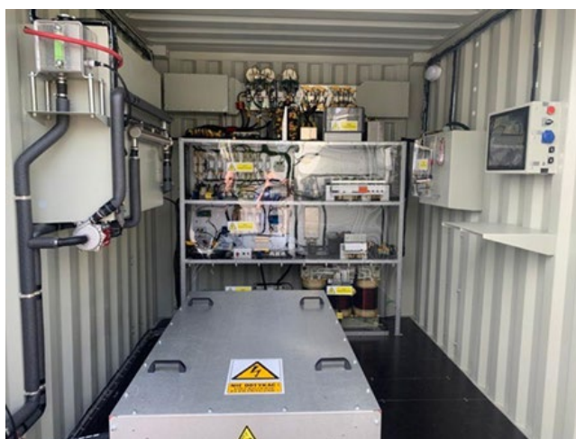
Rysunek 5: Magazynowanie energii elektrycznej w oparciu o akumulatory; wykorzystanie „drugiego życia” baterii trakcyjnych trolejbusów. Źródło: PKT.
