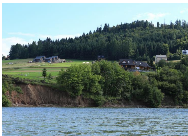
Fig. 45 Czorsztyń reservoir shore abrasion, Falsztyn. Photo: E. Zajac
