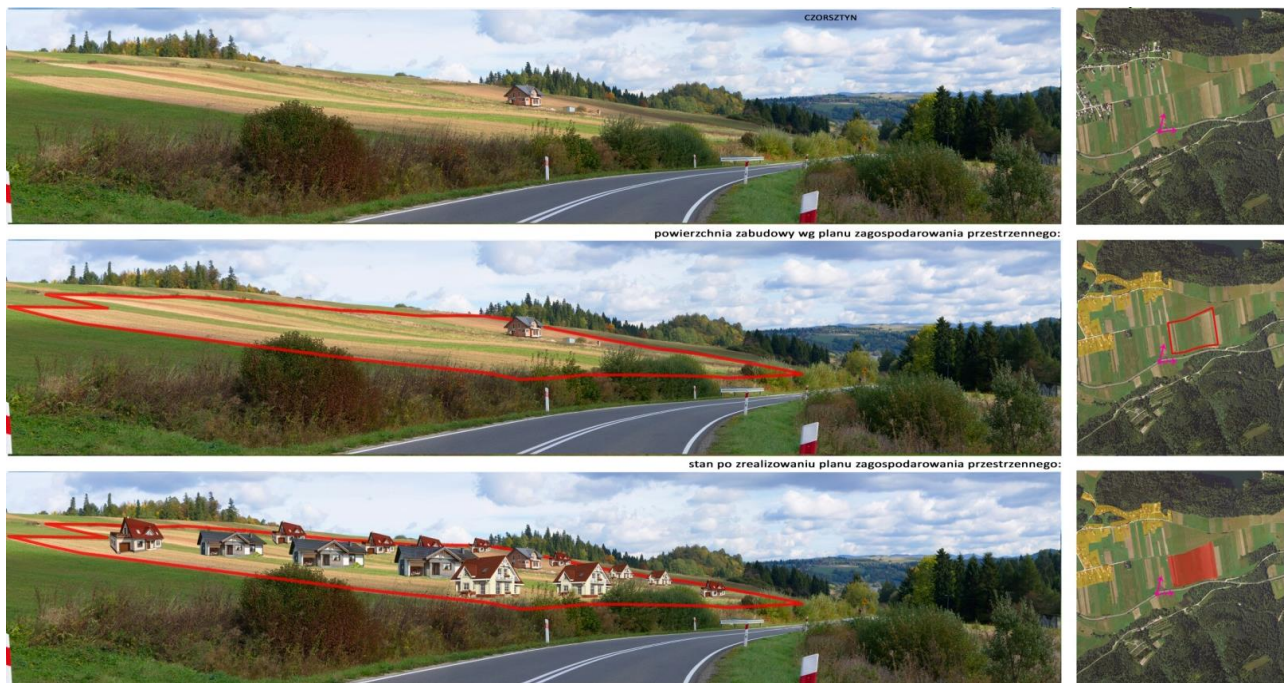
Ryc. 47. Zabudowa terenu osuwiskowego we wsi Falsztyn w otulinie Pienińskiego PN - na ilustracji u góry istniejący w 2013 r. pojedynczy budynek, na ilustracji poniżej granice obszaru zabudowy dopuszczonej ustaleniami mpzp, na dolnej ilustracji wizualizacja możliwej dalszej zabudowy terenu osuwiskowego - potencjalne naruszenie stabilności stoku grożące osunięciem terenu wraz z budynkami oraz nieodwracalne negatywne zmiany w krajobrazie otuliny Pienińskiego PN. Autorzy wizualizacji: D. Brachaczek, N. Figzał, M. Szarnicka
