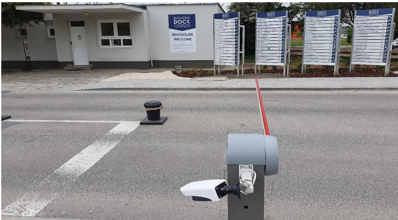
5. Kép - Rendszámfelismerő kamera és sorompó helyzete a kapunál.
