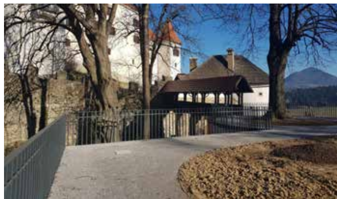
Foto 39-42: In alto a sinistra-Prima dei lavori di sistemazione In basso a sinistra e a destra - Dopo i lavori
