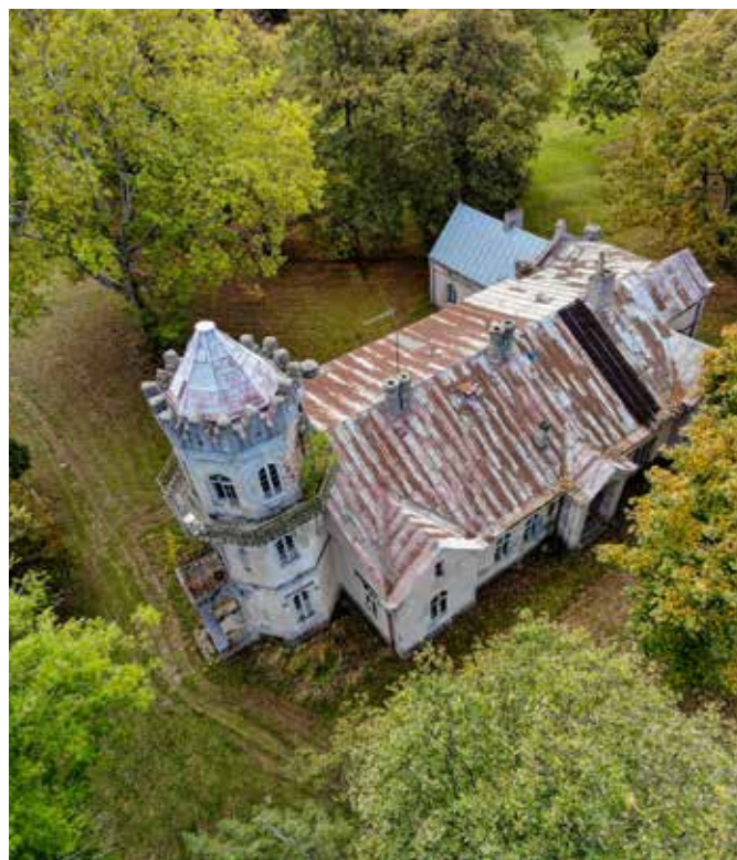
Foto 29: In alto a sinistra - Visualizzazione 3D del nuovo concetto Foto 30-31: In basso a sinistra e a destra - Situazione attuale
